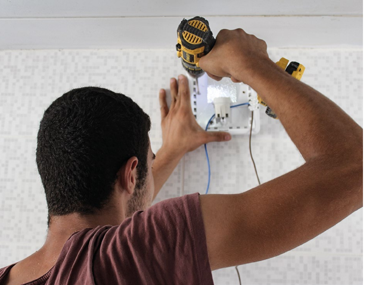
Çıraklık okulu öğrencisi Mehmet Göz, Sonuç Odaklı Eğitim projesi kapsamında, elektrik aksamalarının montajını yapıyor.
